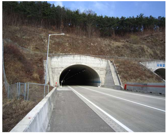
5공구 중구터널(영천) (5공구) 종점부
