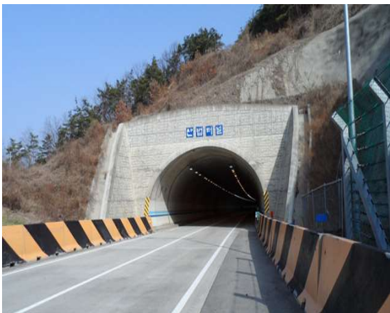
4공구 산법터널(상주방향) (4공구) 시점부
