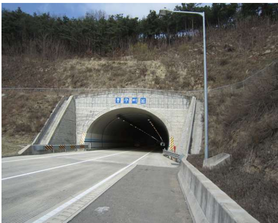
5공구 중구터널(상주) (5공구) 시점부
