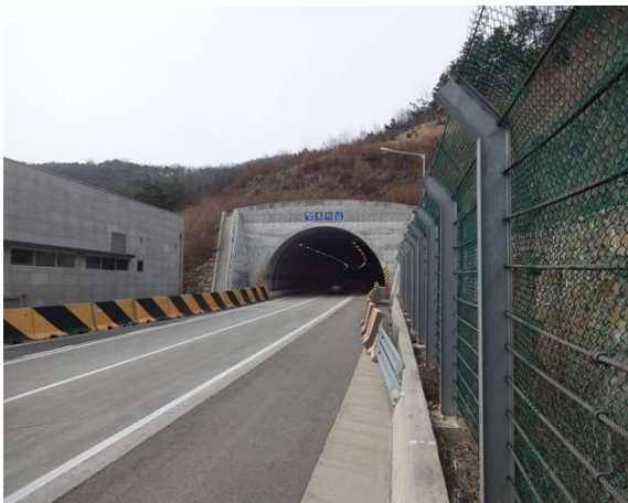
4공구 평호터널(상주방향) (4공구) 시점부
