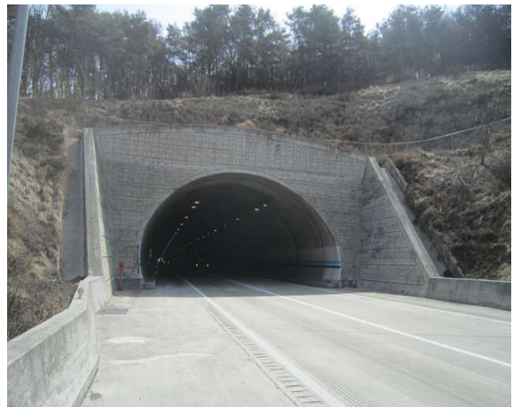
5공구 효령터널(상주방향) (5공구) 종점부
