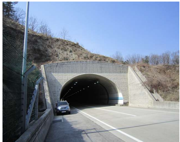
5공구 불로터널(영천) (5공구) 종점부
