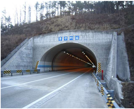
5공구 중구터널(영천) (5공구) 시점부
