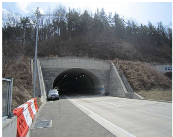
5공구 중구터널(상주) (5공구) 종점부
