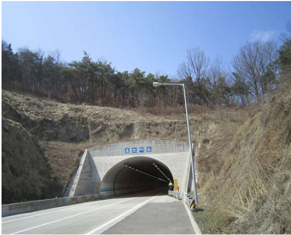
5공구 불로터널(상주) (5공구) 시점부
