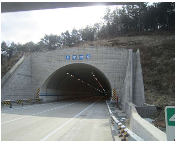
5공구 효령터널(영천방향) (5공구) 시점부
