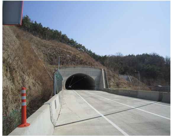
5공구 불로터널(상주) (5공구) 종점부
