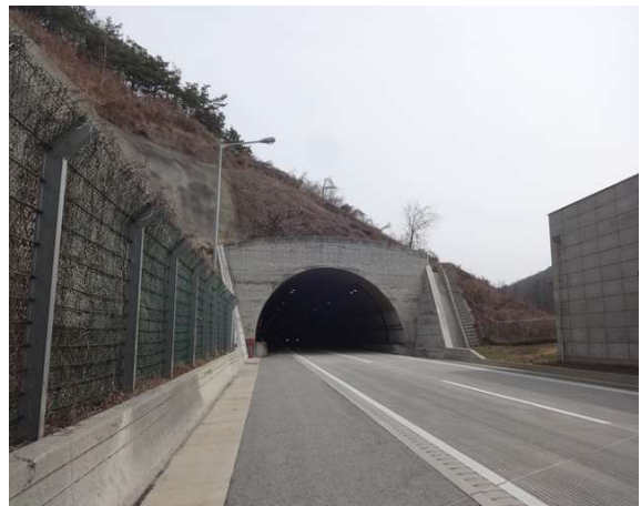
4공구 평호터널(상주방향) (4공구) 종점부
