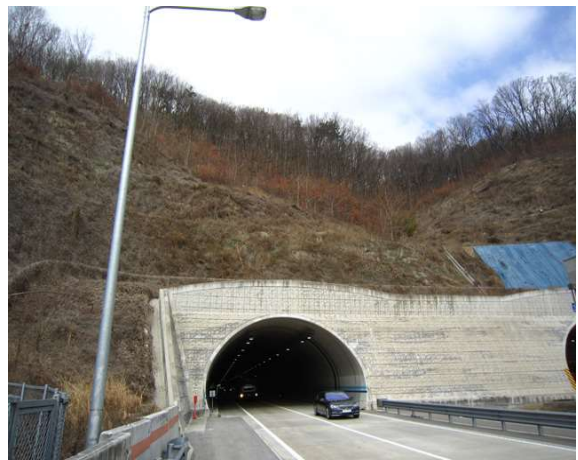
5공구 효령터널(영천방향) (5공구) 종점부
