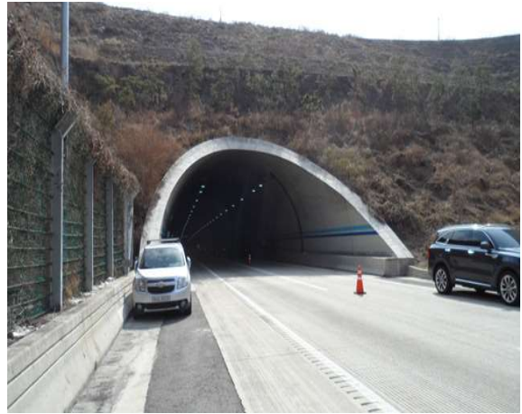
3공구 군위터널(상주방향) (3공구) 종점부
