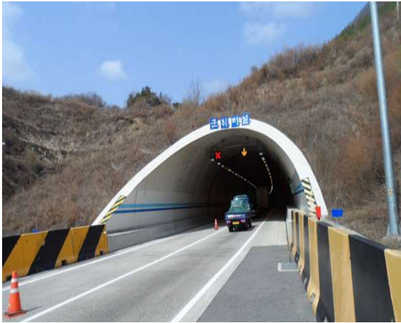
3공구 군위터널(상주방향) (3공구) 시점부
