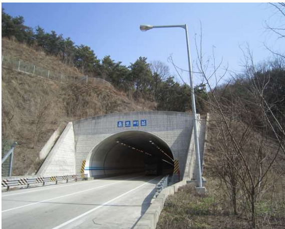
5공구 불로터널(영천) (5공구) 시점부
