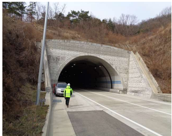
4공구 평호터널(영천방향) (4공구) 종점부
