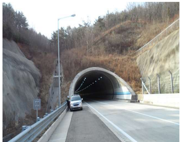
4공구 산법터널(상주방향) (4공구) 종점부
