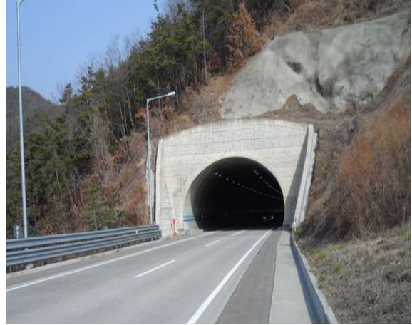
4공구 산법터널(영천방향) (4공구) 종점부
