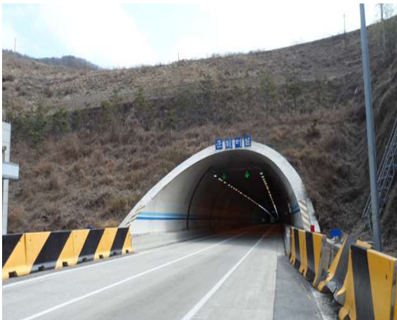
3공구 군위터널(영천방향) (3공구) 시점부
