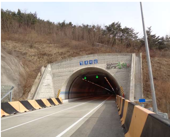
4공구 평호터널(영천방향) (4공구) 시점부
