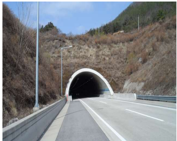
3공구 군위터널(영천방향) (3공구) 종점부
