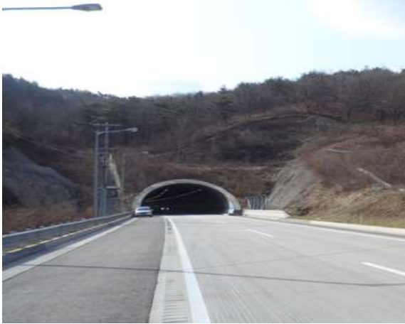
4공구 산법터널(영천방향) (4공구) 시점부
