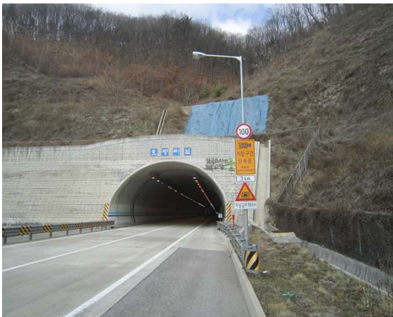
5공구 효령터널(상주방향) (5공구) 시점부
